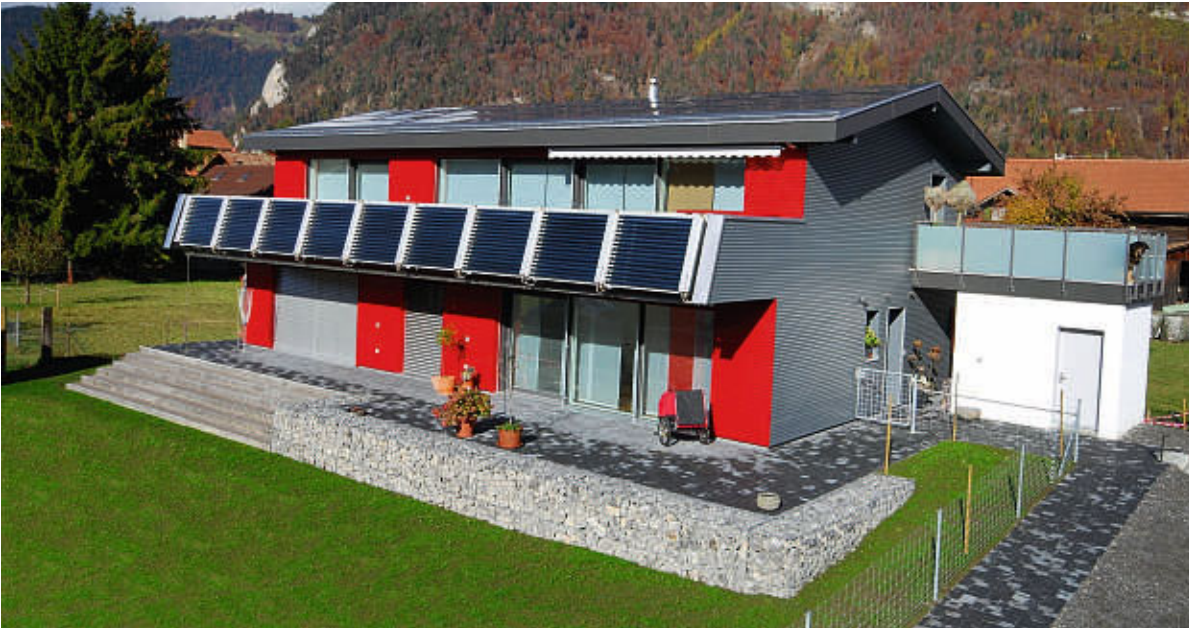
In Matten bei Interlaken wurde das zweite Minergie-A-Eco-Haus der Schweiz zertifiziert.
